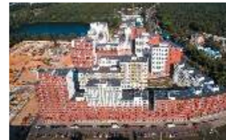
ЖК «Новокрасово», МО «Тройка РЭД»
